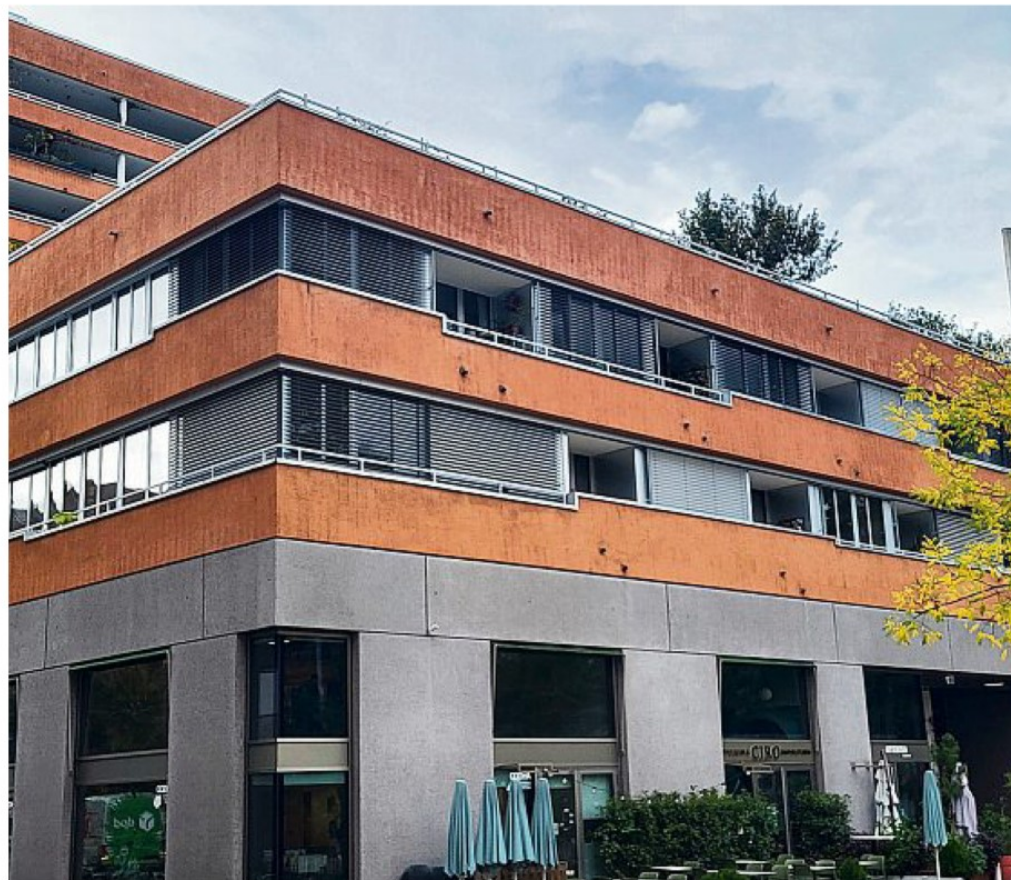
L'immeuble de l'écoquartier de la Jonction où se trouve le siège de la CODHA. FK
