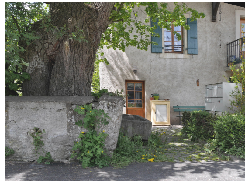
muret, fontaine et frontage de la ferme Mumenthaler
