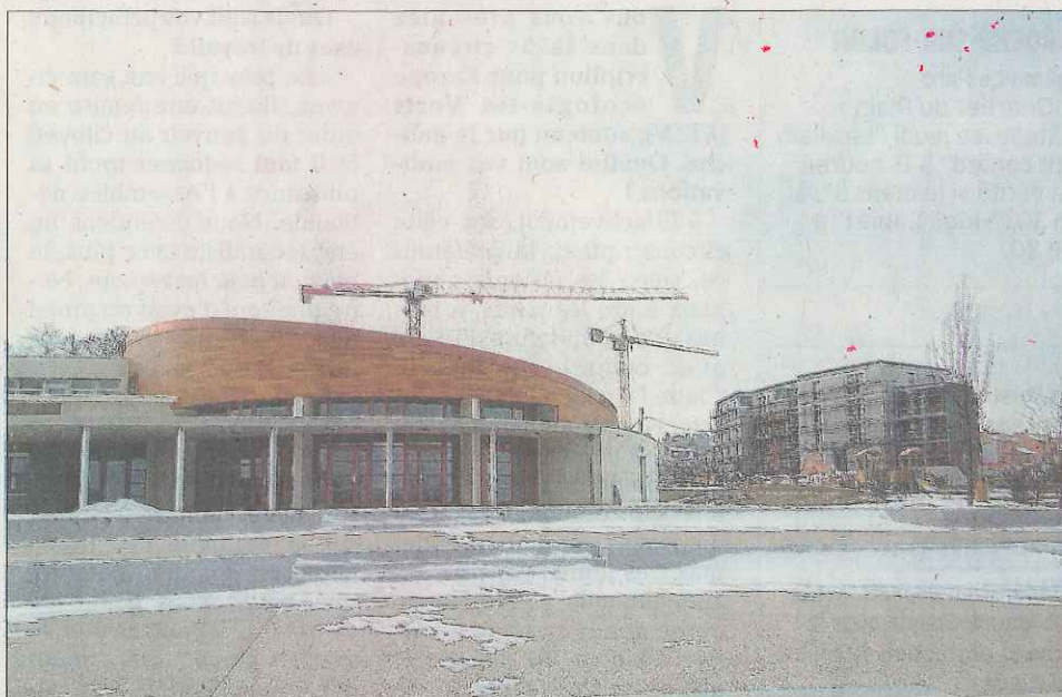
Le nouvel espace culturel Ellipse doit son nom à la forme de son toit, au centre du quartier Ecovela. Photo DL/P.W.
