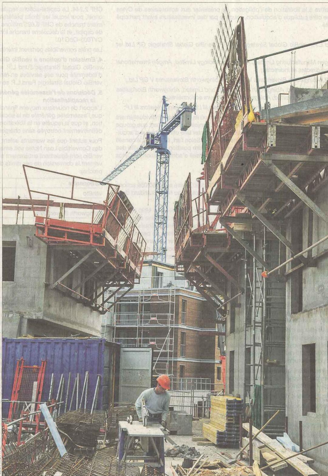
Ci-dessus, le chantier mixte. Ci-dessous, les trois immeubles de conception franco-suisse tels qu'ils apparaîtront en 2013. VIRY, 21 MARS 2012.
