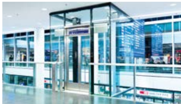
Dans la gare d'Aarau, la transparence des ascenseurs permet une belle visibilité.
